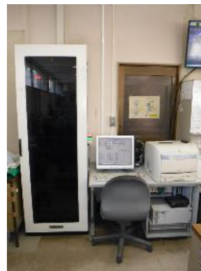
追加で設置（統合時に移設）された 小型個別システム（旧簡易水道の監視システムと、旧河川流量管理システム）
