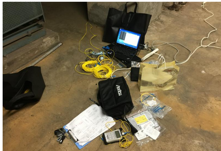
素人 ファイバー 接続工事
